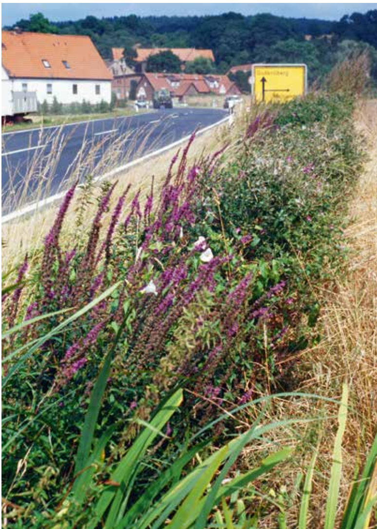
Straßenseitengräben müssen regelmäßig von Schlamm und Bewuchs gereinigt werden.
