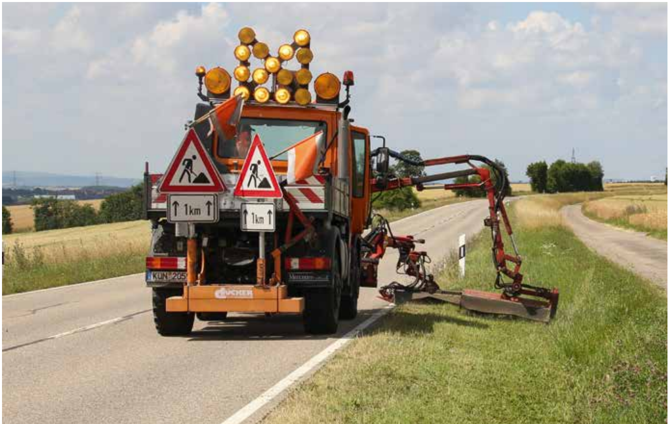
Pflege des Intensivbereichs mit Randstreifenmähergerät und Böschungsmähergerät.
