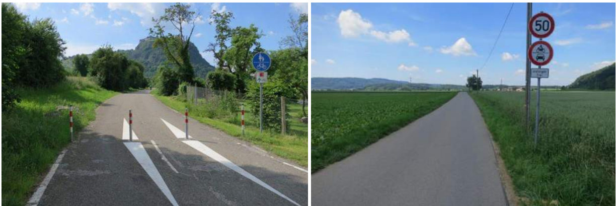
Abb. 33: Führungsformen außerorts: Selbstständiger Geh- und Radweg (Roseneggstraße, Singen) und ein Kfz-freier Weg (Hofenackerstraße, Singen)
