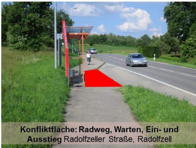
Abb. 40: Der benutzungspflichtige Radweg führt direkt durch den Warte- und Einsteigebereich (Bild links); Die RVA wird getrennt von Warte- und Einsteigebereich geführt (Bild rechts).
