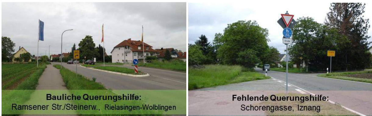
Abb. 39: Mittels baulicher Querungshilfe gesichertes Ende eines Zweirichtungsradweges (links) und fehlende Querungshilfe (rechts)
