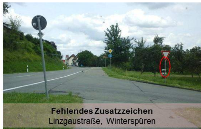
Abb. 44: Kennzeichnung eines Zweirichtungsradweges mit veraltetem Zusatzzeichen 1000-33 und fehlendes Zusatzzeichen sowohl unter dem Radwegeschild als auch über dem Vorfahrtszeichen
