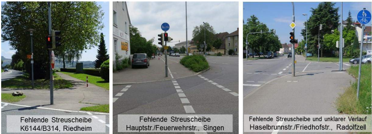
Abb. 45: Fehlendes Fahrradsymbol (Bild links); Signalisierung für den Radverkehr über das Kfz-Signal (2. Bild von links); Doppelte Signalisierung für den Radverkehr: Kfz-Signal und nachfolgendes Fahrradsignal (2. Bild von rechts); Signalisierung gemeinsam mit Fußgängern (Bild rechts)
