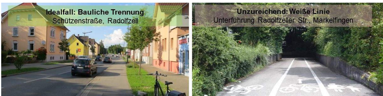
Abb. 35: Bauliche Trennung zwischen RVA und Gehweg
