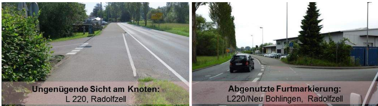
Abb. 38: Gute Sichtbeziehungen, aber eine abgenutzte Furtmarkierung (rechts); Randbewuchs vermindert die Sicht zwischen den Verkehrsteilnehmern (links).
