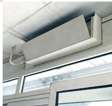
Beheizte Zuluftanlage (Innen- und Außenansicht)
