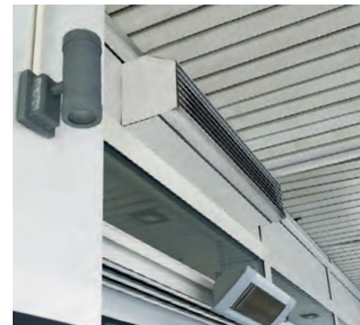
Beheizte Zuluftanlage (Innen- und Außenansicht)
